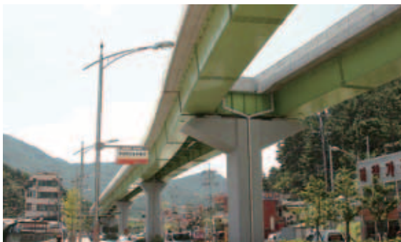
図7 国道上区間高架橋分岐部
