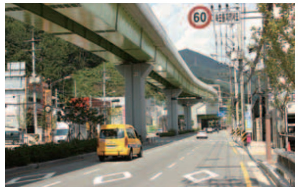
図5 国道上区間高架橋
