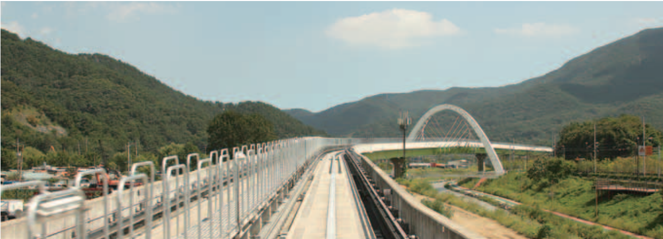
図3 シンボルとしての直行型アーチ斜張橋（渡河橋梁部 1）
