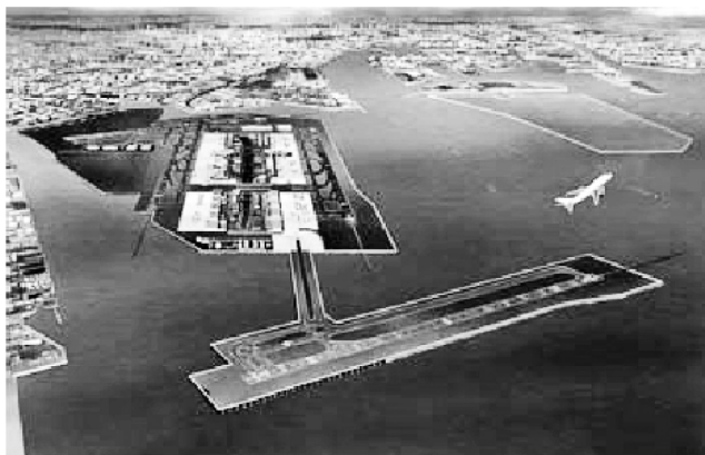
2010 年 10 月に完成した羽田空港第 4 滑走路
